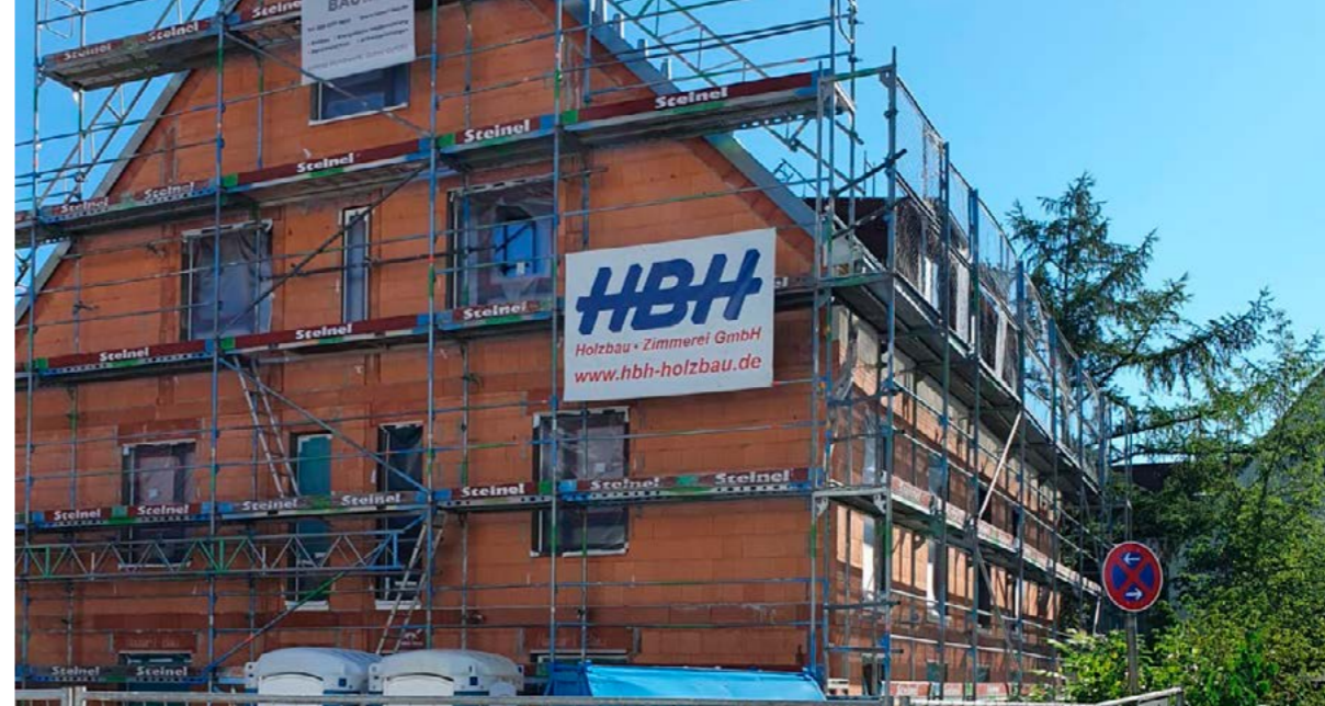
Foto: Neubau von außen. Bild: KJSW/Wübbeling
